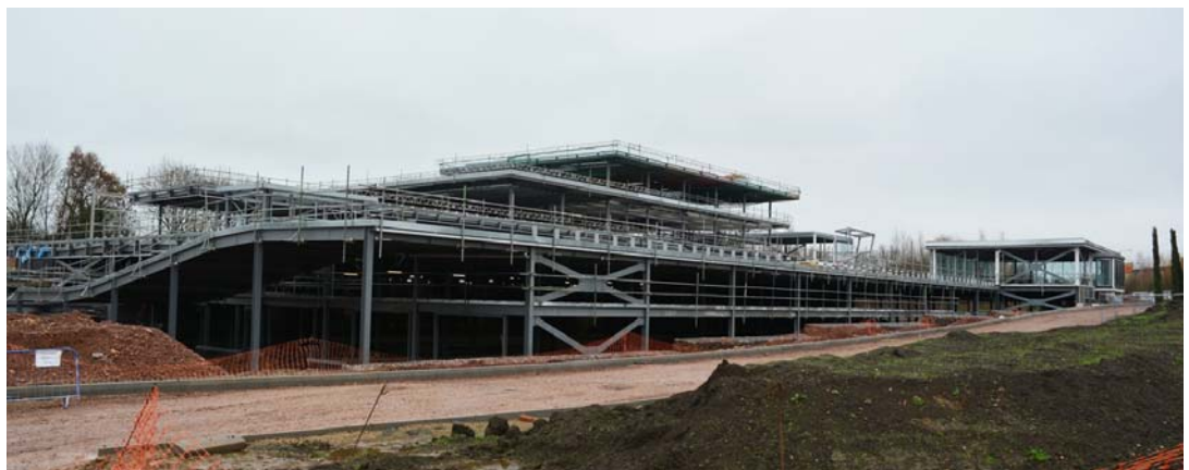
BMW Mini Dealership under construction 2015
